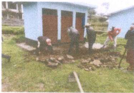
Foto 15: FUNDICION DE PISO FRENTE A SANITARIOS
