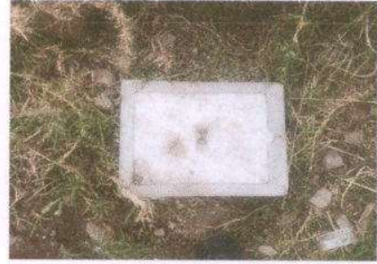
Foto 8: SUSTITUCION DE CAJA DE REGISTRO
