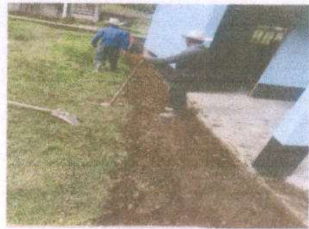
Foto 16: FUNDICION DE BANQUETA
