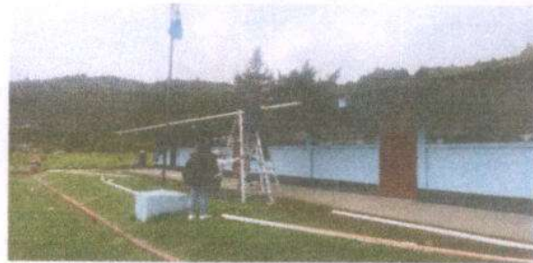
Foto 4: SUSTITUCION DE CANAL PVC
