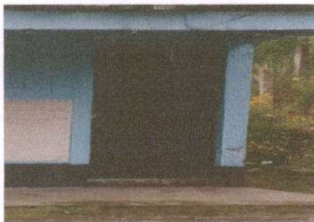
Foto 17: PINTURA DE PUERTA DE METAL
