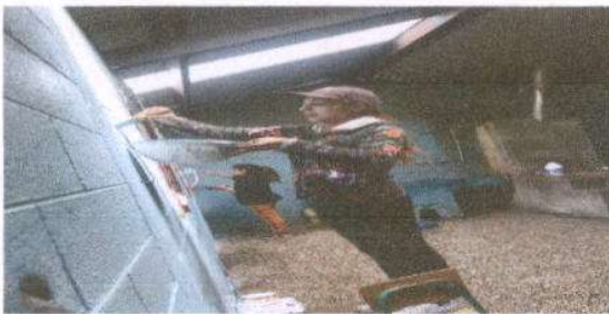
Foto 5: PINTURA EN MUROS EXTERIORES E INTERIORES
