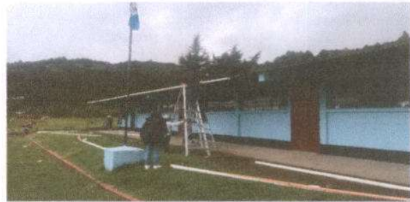
Foto 4: SUSTITUCION DE CANAL PVC
