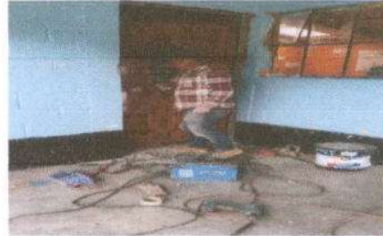
Foto 2: SUSTITUCION DE PUERTA DE MADERA POR METAL
