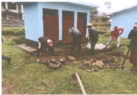
Foto 15: FUNDICION DE PISO FRENTE A SANITARIOS
