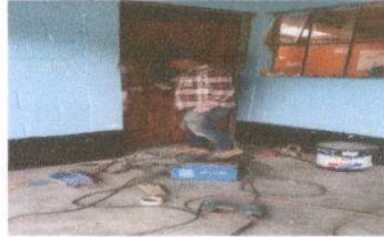
Foto 2: SUSTITUCION DE PUERTA DE MADERA POR METAL
