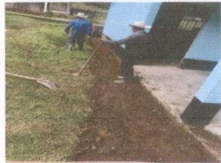
Foto 16: FUNDICION DE BANQUETA
