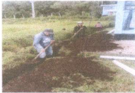
Foto7: SUSTITUCION DE TUBERIA PVC LINEA PRINCIPAL AGUAS NEGRAS 3"
