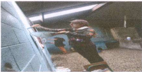
Foto 5: PINTURA EN MUROS EXTERIORES E INTERIORES
