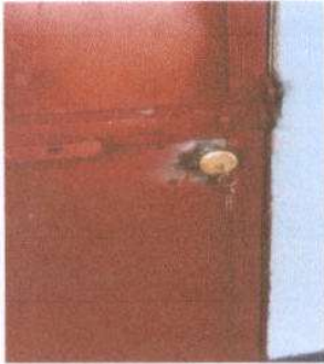
Foto 13: CAMBIO DE CHAPAS MARCA YALE
