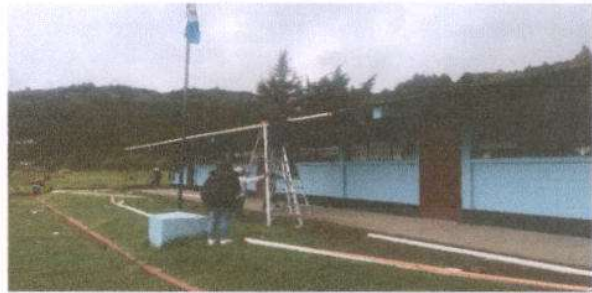
Foto 4: SUSTITUCION DE CANAL PVC
