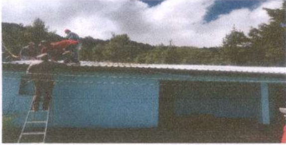
Foto 1: SUSTITUCION DE LAMINA, POR LAMINA TROQUELADA ALUZINC ALIBRE 26
