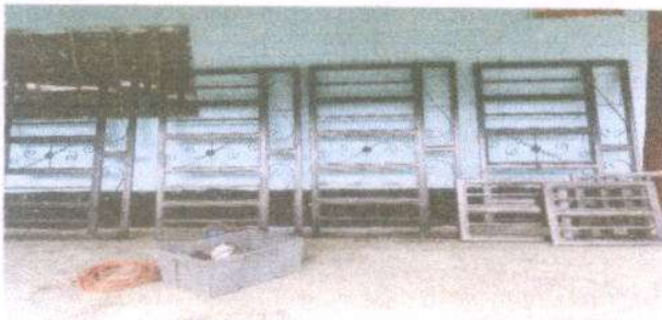
Foto 3: SUSTITUCION DE VENTANAS DE MADERA POR METAL MAS VIDRIO
