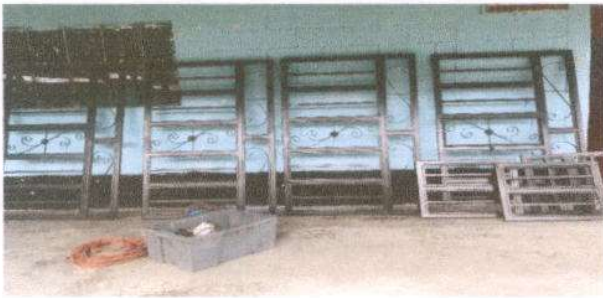
Foto 3: SUSTITUCION DE VENTANAS DE MADERA POR METAL MAS VIDRIO
